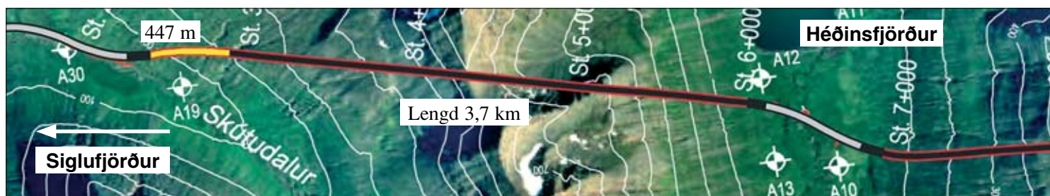
Staða framkvæmda við Héðinsfjarðargöng 27. nóvember 2006. Búið er að sprengja 447 m í Siglufirði og 137 m í Ólafsfirði.
